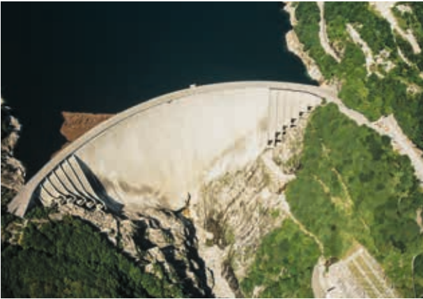
2 Die Contra-Staumauer (1960–1965) im Verzascatal von Giovanni Lombardi, dessen Büro als eines der ersten Berechnungen mit Computerhilfe erstellte. Le barrage de Contra (1960–1965), conçu par Giovanni Lombardi dans le Val Verzasca. Le bureau a été l'un des premiers à faire des calculs sur ordinateur. La diga di Contra (1960–1965) in val Verzasca, progettata da Giovanni Lombardi, il cui studio è stato uno dei primi ad eseguire calcoli assistiti da computer.
