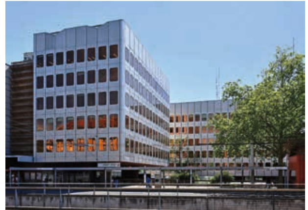
3 Das Ensemble Chauderon (1969–1974) in Lausanne von AAA: Jean Prouvé arbeitete bei der Entwicklung der vorfabrizierten Fassadenelemente mit. L'ensemble Chauderon (1969–1974) à Lausanne par AAA: Jean Prouvé a collaboré au développement des éléments de façade préfabriqués. L'Ensemble Chauderon (1969–1974) a Losanna di AAA: Jean Prouvé ha collaborato allo sviluppo degli elementi prefabbricati della facciata.
